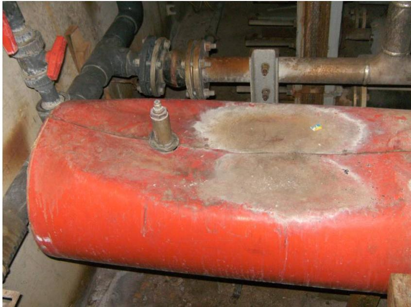
Abb. 8 – Rohrbündelwärmetauscher „Braune Grotte“ Betrieb mit unbehandeltem Thermalwasser
