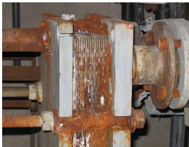
Abb. 9 – Plattenwärmetauscher Betrieb mit gereinigtem Thermalwasser
