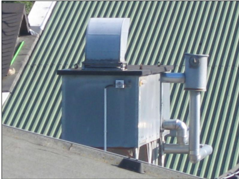
Abb. 4 – Wärmerückgewinnung an der Ablufteinheit der Lüftung der Schwimmhalle
