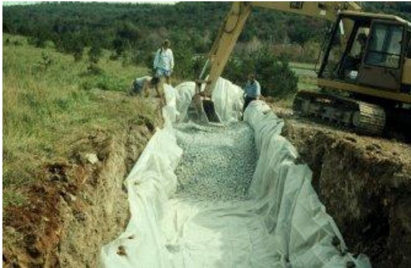
Abb. 19: Bau eines ALD (SKOUSEN et al, 1998)
