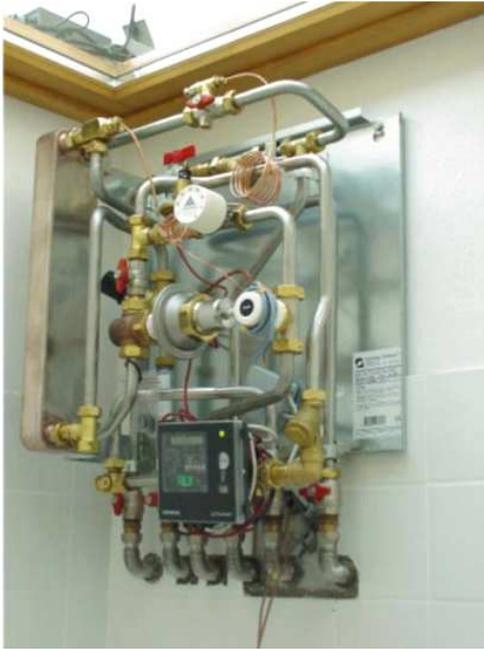
**Abb. 11: Vormontierte Wohnungsstationen sind platzsparend und erleichtern die Montage.<sup>1</sup>**
