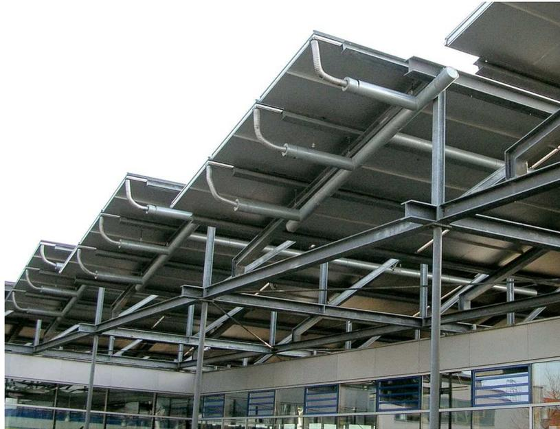
**Abb. 18: Ausschnitt aus der freitragenden Dachkonstruktion über der Sporthalle in Neckarsulm-Amorbach mit 1252m<sup>2</sup> Kollektorfläche<sup>1</sup>**
