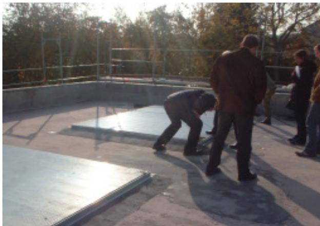
**Abb. 5:** Deckel der Brennstoffbunker (Heizzentrale in Wörth)
