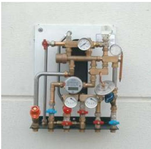
Abbildung 6 zeigt eine Hausübergabestation für ein Einfamilienhaus. Sie wird in der Regel im Keller an der Wand montiert und dann nach außen an das Nahwärmenetz und im Haus an den Heizwasserkreislauf des Gebäudes angeschlossen.
