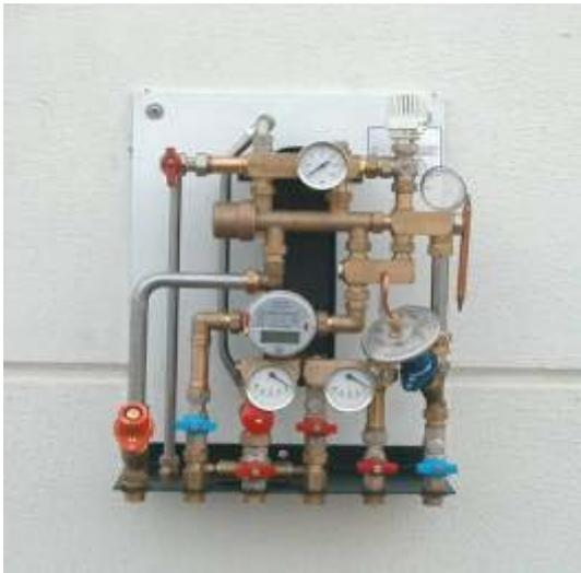
Abbildung 5 zeigt eine Hausübergabestation für ein Einfamilienhaus. Sie wird in der Regel im Keller an der Wand montiert und dann nach außen an das Nahwärmenetz und im Haus an den Heizwasserkreislauf des Gebäudes angeschlossen.
