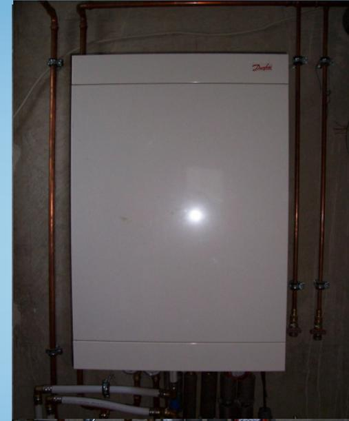
Heizungsauslegung Radiatoren 60 °C / 30 °C, zum Teil Fußbodenheizung
