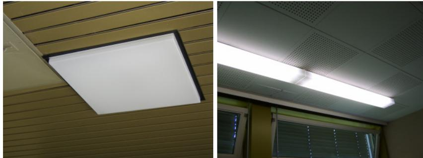
**Abbildung 9-1 Opalglaswanne mit Leuchtstoffröhre im Altbau**
