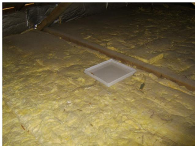
**Abbildung 8-2** Wärmedämmung Dachboden
