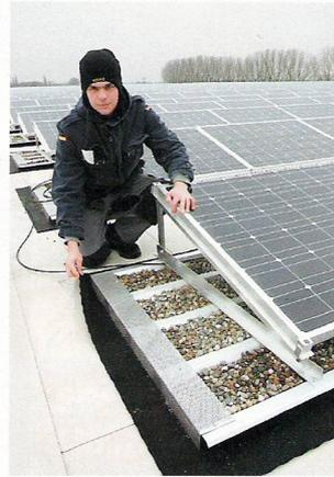
Bautenschutzmatzen und darauf mit Kies beschwerte Aluminiumwannen: Die Solartechniker müssen auf die Dachhaut achten.
