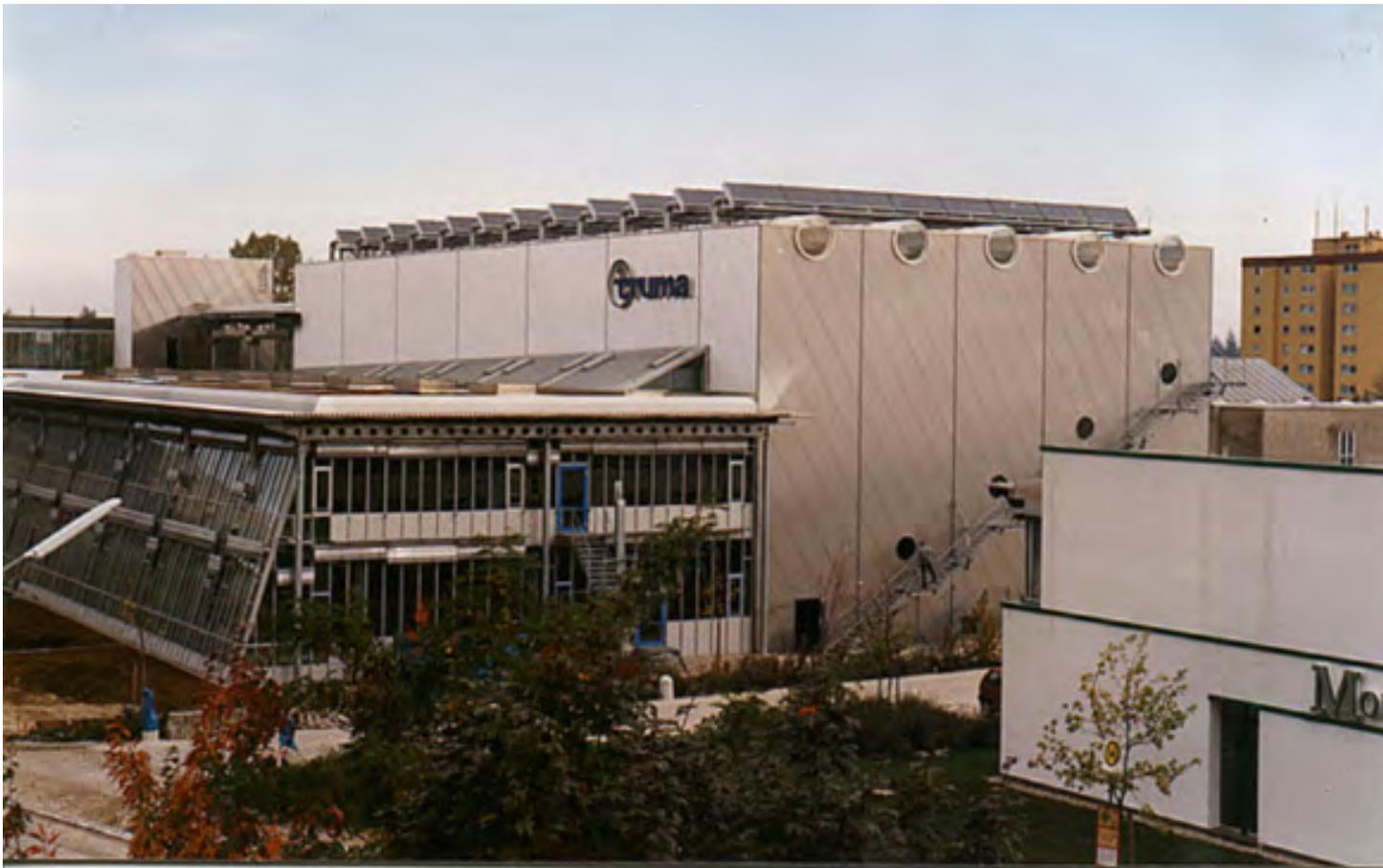
210 m<sup>2</sup> GLK, Flachdach, 141 kWp,therm.
