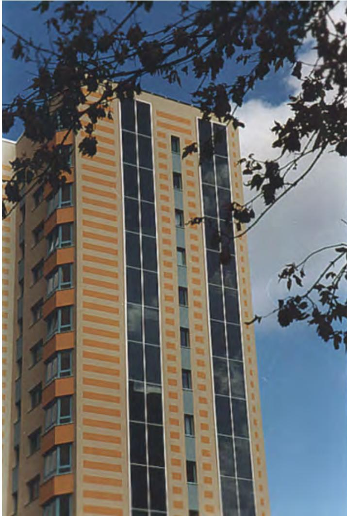
Im Zuge der Fassadenrenovierung wurde eine Solar-Luft-Fassade zur Erwärmung der Frischluft für die innenliegenden Nasszellen eingebaut.
