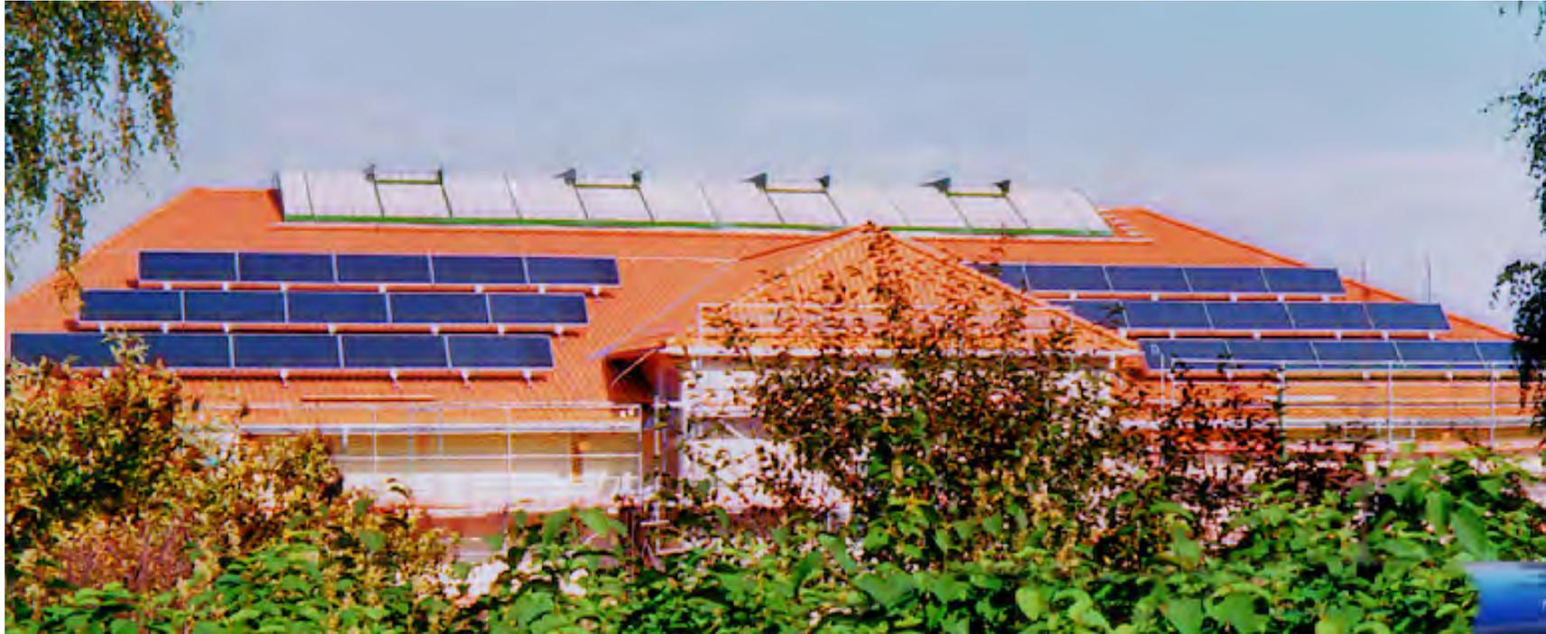
Solar unterstützte Luftheizung und Frischluftherwärmung zur Lufterneuerung
