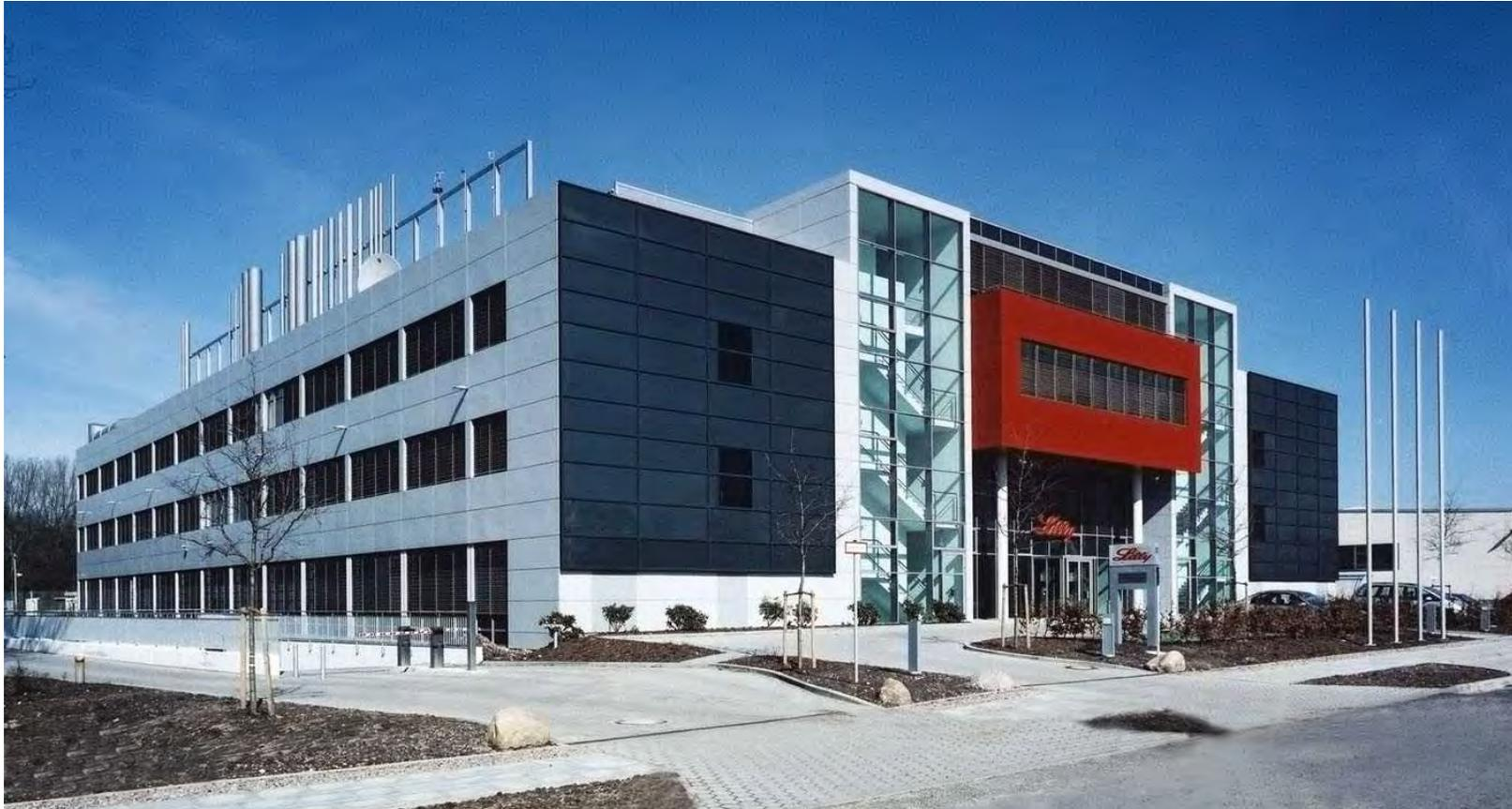
Solar-Luft-Fassade zur Versorgung der Lüftungsanlage
