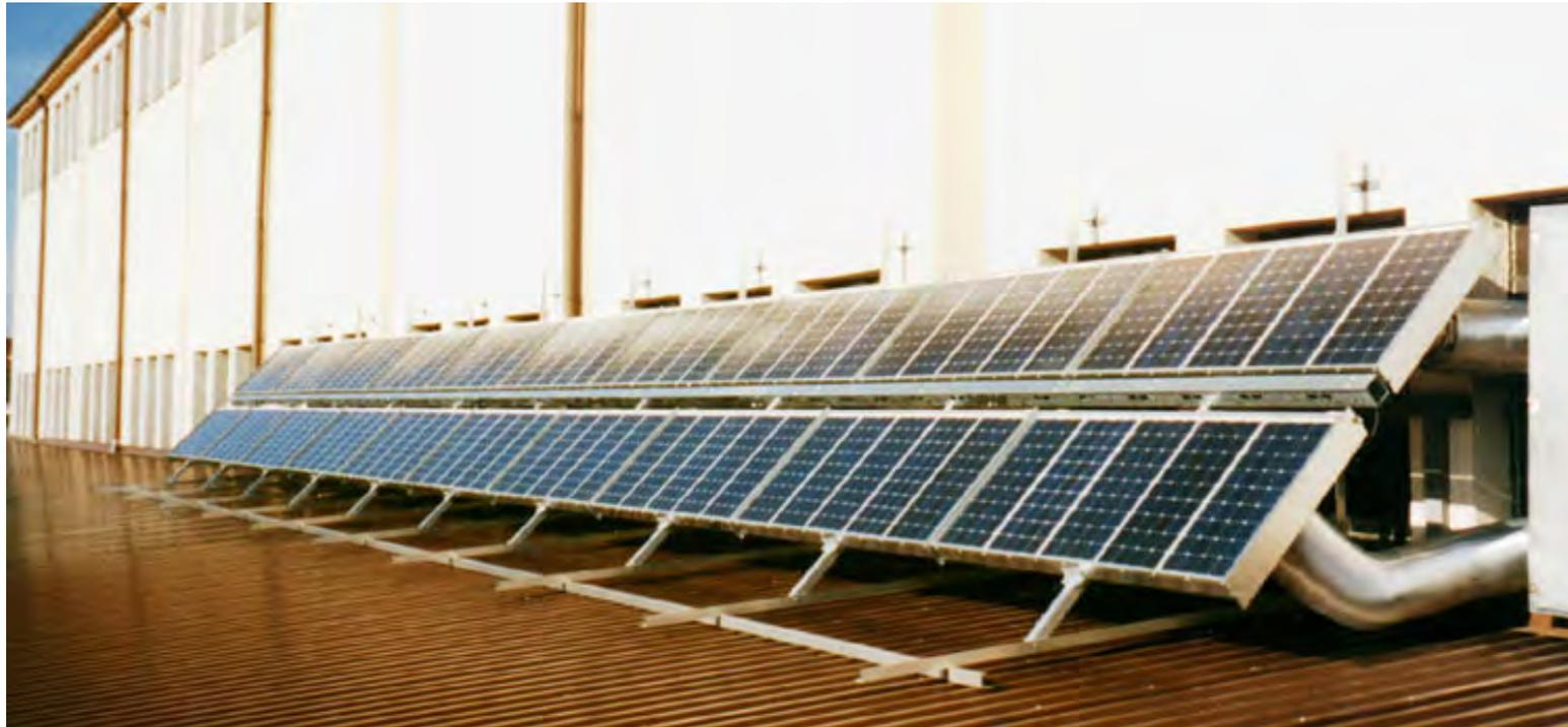
Frischluftherwärmung (Lackieranlage) + Strom zur Netzeinspeisung
