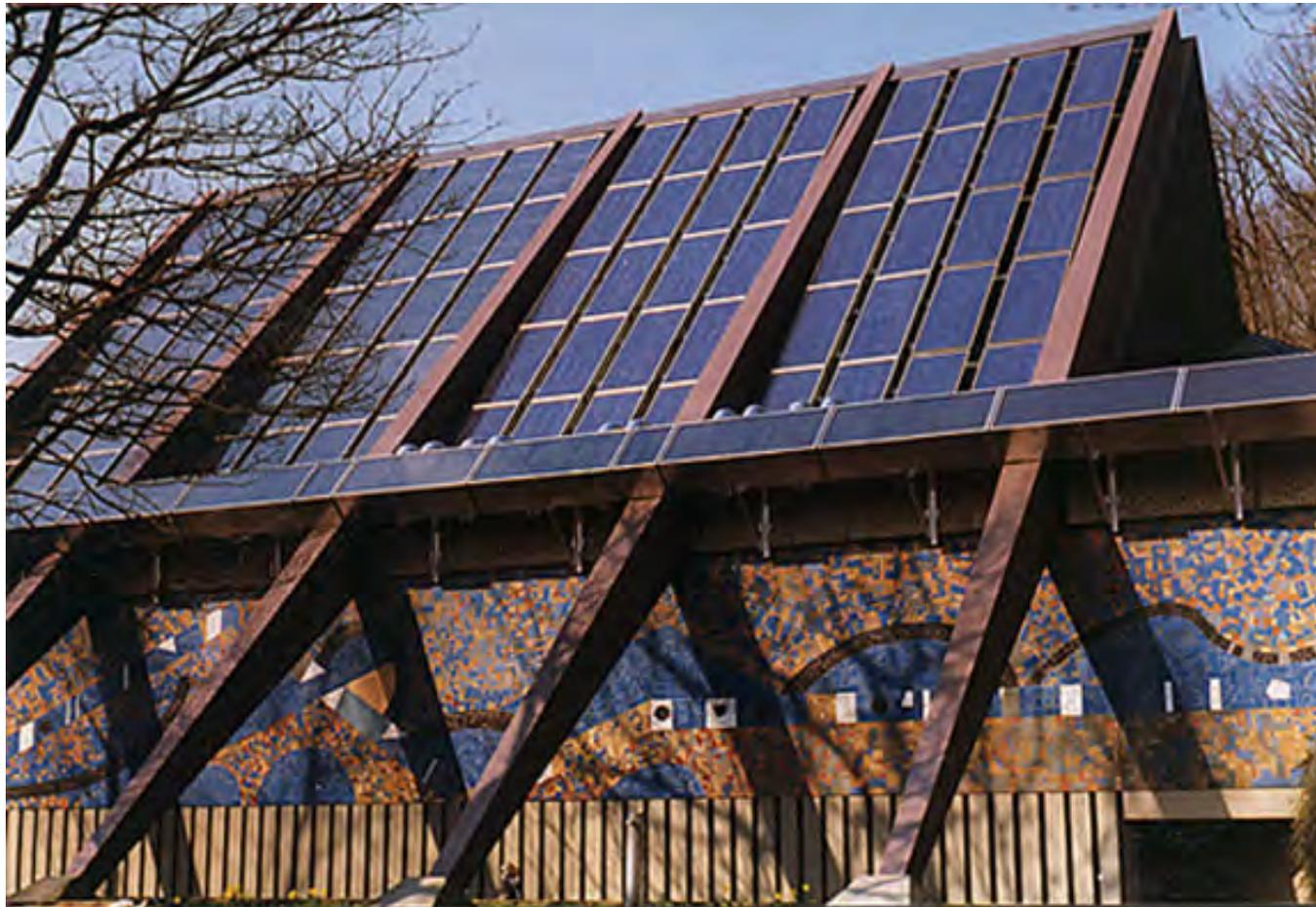
Frischluffterwärmung (Delfinarium) + Strom zur Netzeinspeisung
