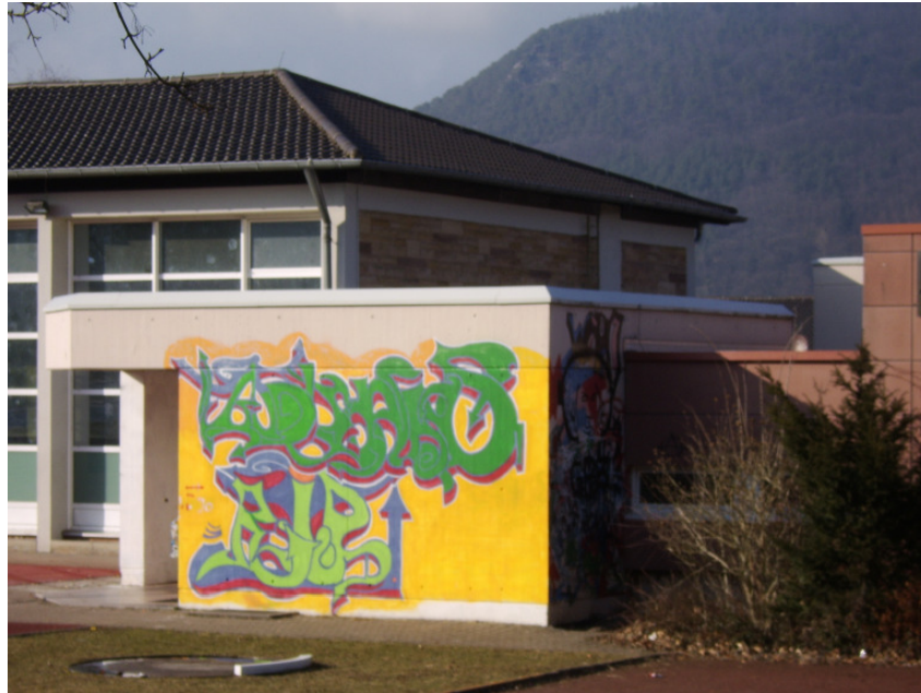
Abbildung 7-2 Übergang zwischen kleiner und großer Turnhalle
