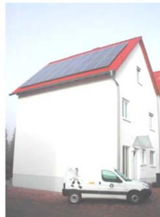
Seine Solarstromanlage besteht aus 24 Solarmodulen der Marke Isofoton mit einer Gesamtleistung von 3,96 kWp (Kilowatt Spitzenleistung). Das Gebäude ist nach Süden ausgerichtet und nicht verschattet, so dass eine optimale Sonnenausbeute erfolgen kann. Die Photovoltaikanlage wurde von Herrn Schwarm mit Unterstützung von drei Helfern innerhalb eines Tages montiert. Der Materialpreis der Anlage betrug ca. 22.000 € incl. Mehrwertsteuer.
