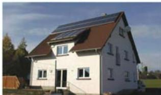
Sie besteht aus 32 Modulen des Herstellers Kyocera mit einer Gesamtleistung von 3,84 kWp und zwei Wechselrichtern des Herstellers SMA. Der erwartete jährliche Stromertrag liegt bei mind. 3.300 kWh und deckt rechnerisch in etwa den Verbrauch der 5-köpfigen Familie. (Der vergangene Sommer lässt hoffen, dass diese vorsichtig geschätzten Werte auch deutlich überschritten werden können. Vorhandene Anlagen hatten im September 2003 schon das prognostizierte Jahressoll erfüllt.)
