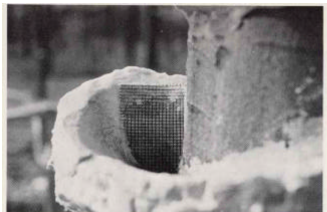
Blick in den Abflusstrichter der Stammabflußrinne
