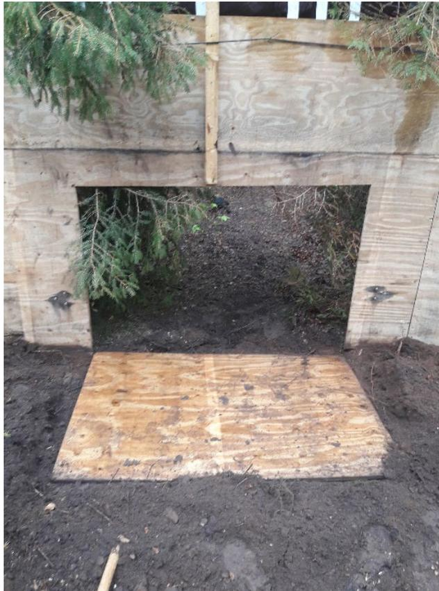
Abbildung 2: Wasserfest verleimte Verbundholzplatte als Untergrabschutz bevor sie mit Erdrich verblendet wurde (Foto: T. Bublitz; ZdF).
