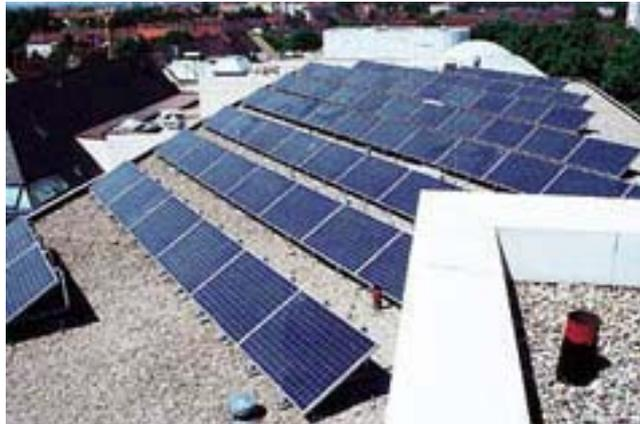
Abbildung 4-3 Fotovoltaikmodule auf dem Dach eines Krankenhauses (Quelle: Solvis)
