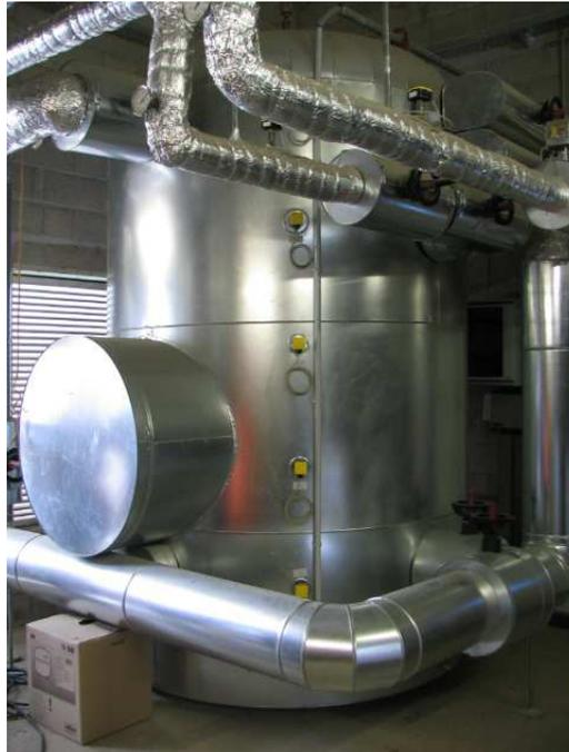
**Abbildung 3: Exemplarisches Bild eines 10 m<sup>3</sup> Pufferspeichers mit Isolierung**
