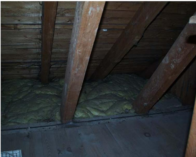
Abbildung 2.3 Dämmung Dachboden
