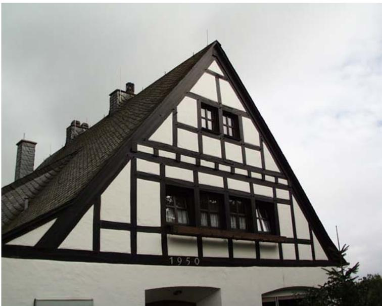
Abbildung 2.4 Fachwerk an der Südseite des Gebäudes
