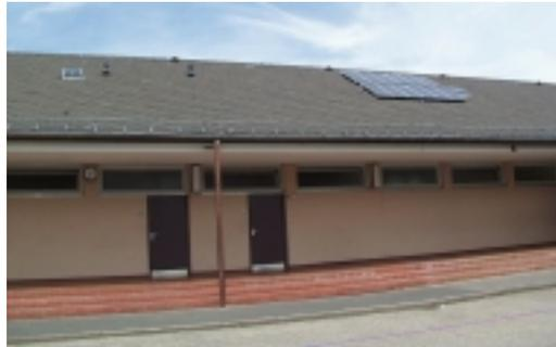
Abbildung 6-6 Fotovoltaikanlage auf Süddach des Ostflügels
