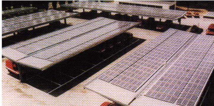
**Abbildung 8: Überdachter Parkplatz aus Photovoltaikmodulen**
