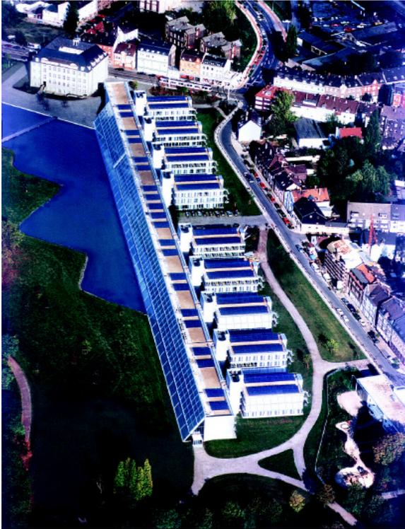
**Abbildung 11: Solarkraftwerk auf dem Dach des Wissenschaftsparks Gelsenkirchen**
