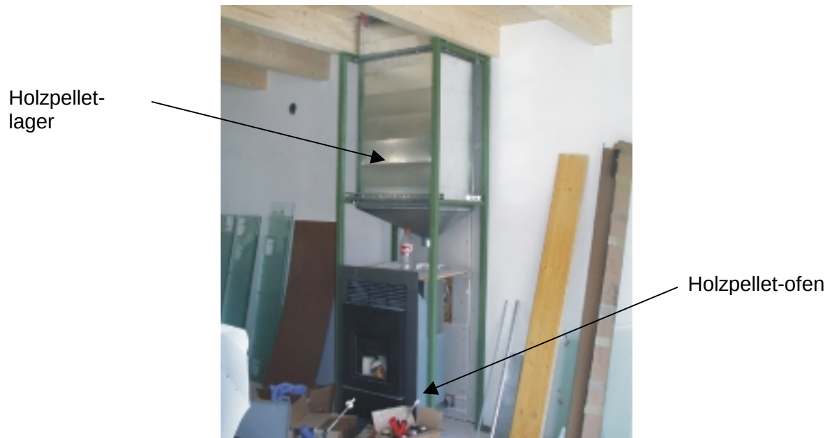
Abbildung 6-1 Holzpelletsofen im Rohbau (Foto: TSB)
