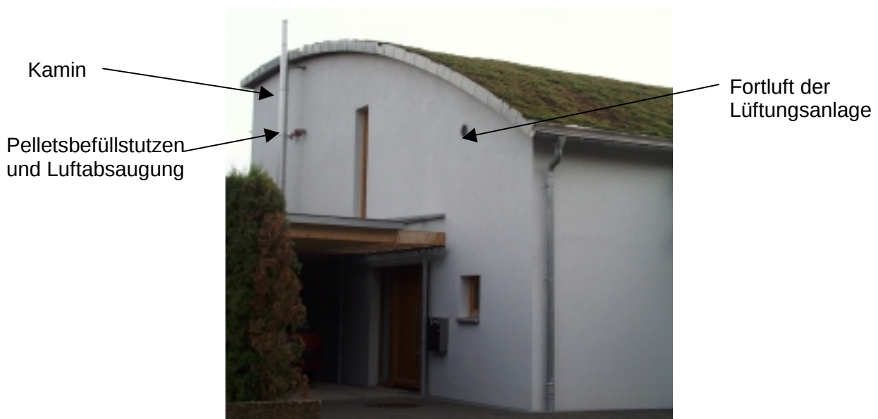
Abbildung 6-2 Befüllanschlüsse Holzpelletslager (Foto: TSB)
