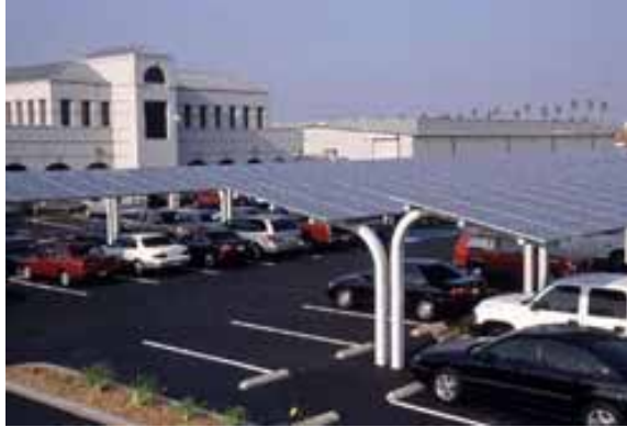
Abb.120: Beispiel Carport mit PV
