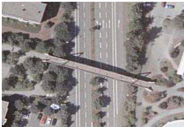
Abb.97: Brücke Süd (Trippstadter Straße)
