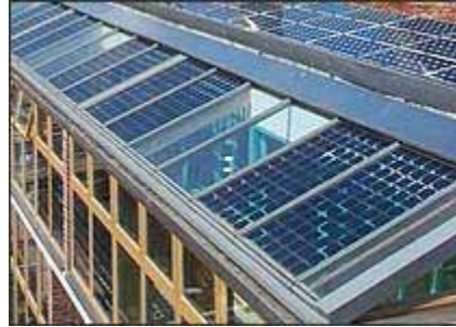
Abb.12: Solarmodule als Überkopfverglasung Quelle: URL: http://www.solarintegration.de/index.php?id=17 , 20/09/2004
