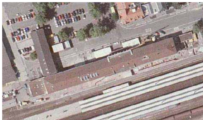
Abb.26: Luftbildaufnahme Bahnhof Kaiserslautern
