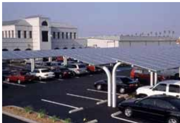
Abb.126: Beispiel Carports mit PV
