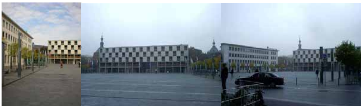
Abb.79: Stiftsplatz mit einem Hotelneubau (Mitte) und einem Bürogebäude links
