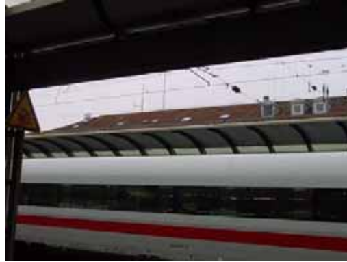
Abb.33: Dach des Bahnhofgebäudes
