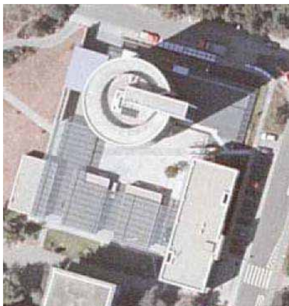
Abb.106: Luftbildaufnahme, Gebäude 47 und 7 2
