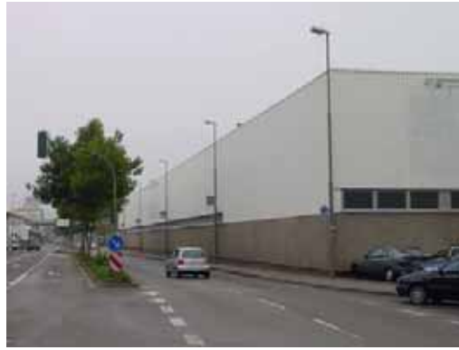
Abb.62: Gebrüder Pfeiffer Vorderansicht (Südansicht)
