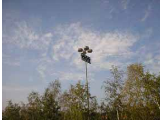
Abb.127: Lichtenanlage des Supermarktes
