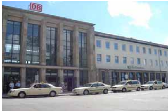
Abb.27: Vorderansicht Bahnhof (Nordansicht)
