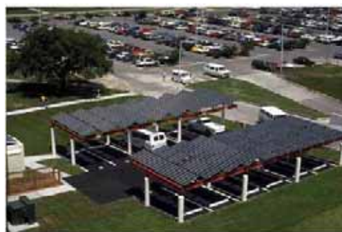
Abb.96: Beispiel solare Überdachung
