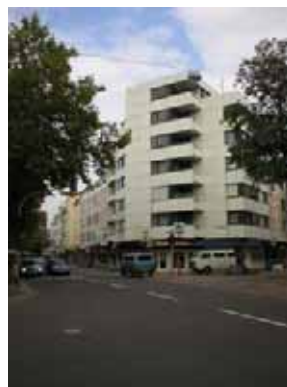
Abb.93: Wohnhaus Südansicht in Richtung Bahnhof
