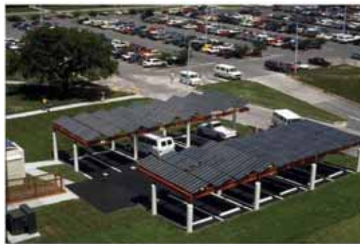
Abb.25: Solare Parkplatz Überdachung
