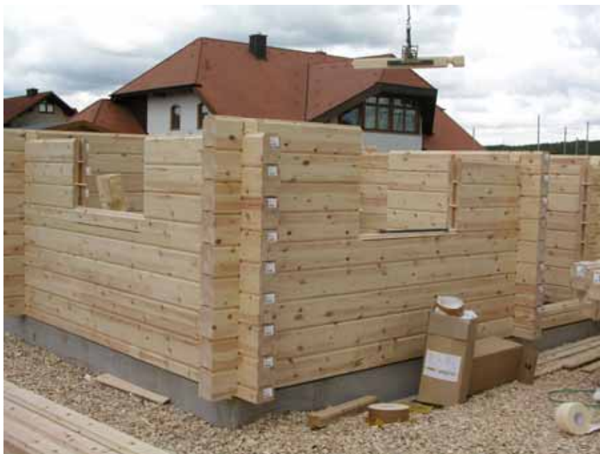
Moderner Holzhausbau. Ästhetik, gute Wärmedämmung und positive Wirkungen auf das Raumklima machen Holz nach wie vor zu einem gefragten Baumaterial. (Foto: M. Jochum)
