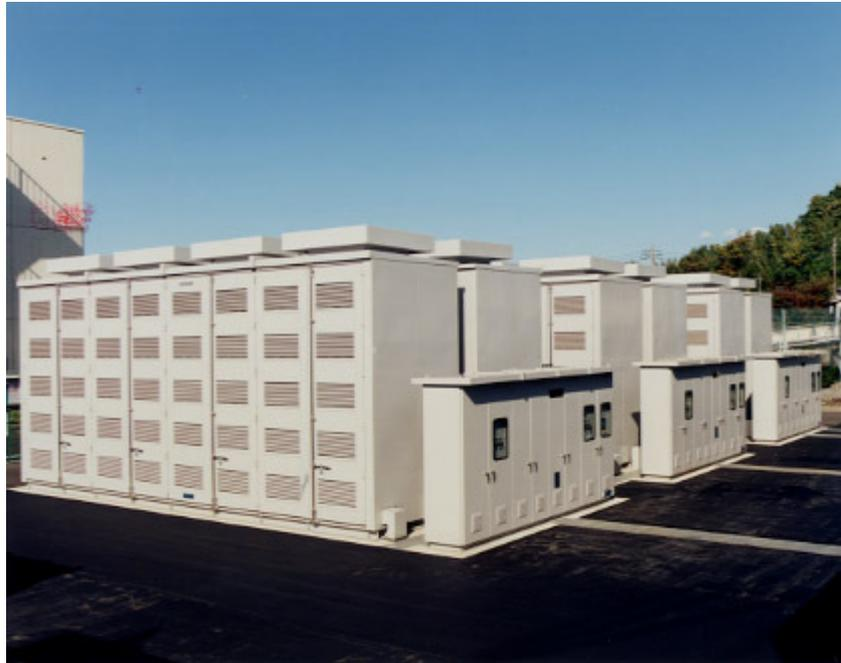
Abbildung 2-12 NaS-Batterien in Ohito Substation zum Ausgleich des Stromtageslastgangs von Banken (Quelle: IERE, Japan)
