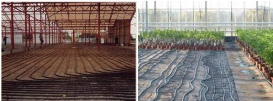
Abbildung 2-8 Bodenheizung und Vegetationsheizung (Quelle: Klaus Kuba GmbH)
